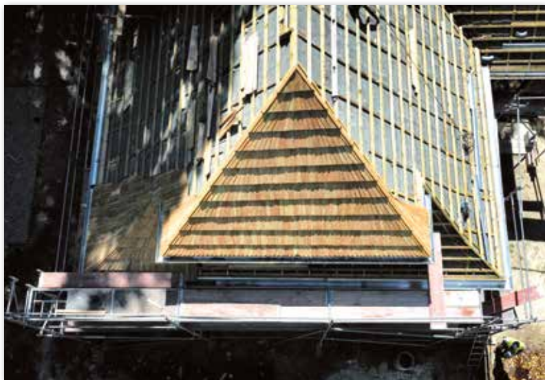
Dach willi z częściowo położonym nowym gontem, sierpień 2024 r. Fot. Filip Dowjat.
